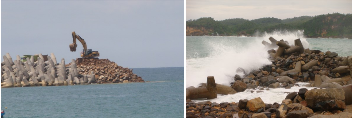
Gambar 6a. Proses rock dumping untuk lapisan bedding layer ; 6b. Kerusakan lapisan bedding layer akibat gelombang.
