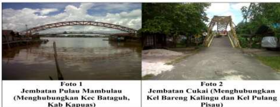
Gambar 5 Jembatan kabupaten Pulang Pisau
